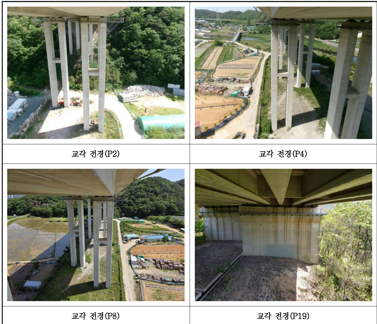
【사진 45.3.14】 교각 전경
