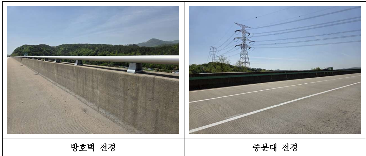
【사진 45.3.28】 방호벽 및 중분대 전경
