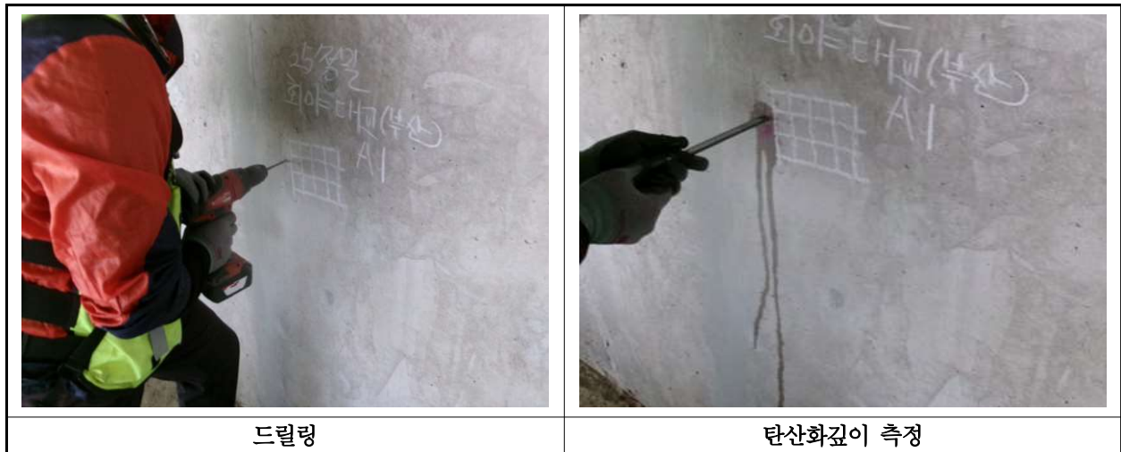
【사진 45.4.3】 탄산화 깊이 측정 현장사진
