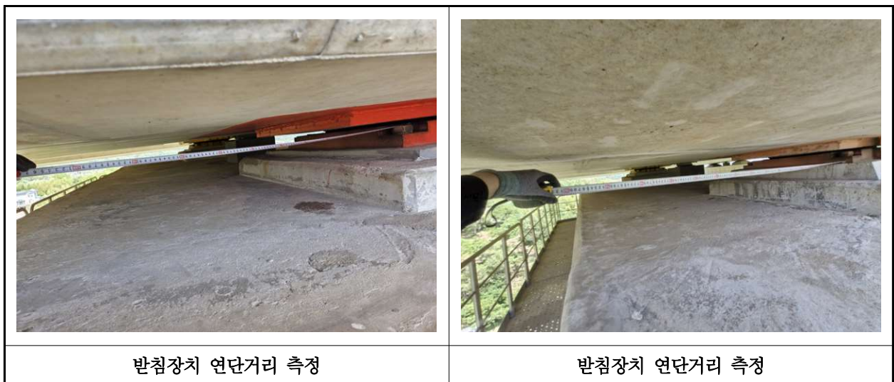
【사진 45.3.19】 교량받침장치 연단거리측정
